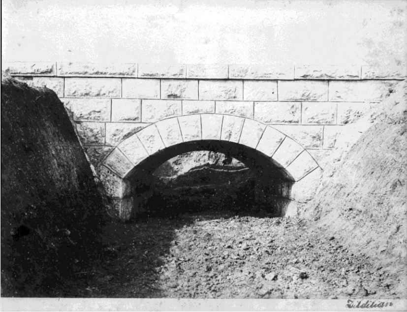
Dildilyanlar'ın çektiği ve sağ altta imzaları bulunan Kastamonu'dan Taşköprü ve Daday'a uzanan yollarda her biri üçer metre açıklığında inşa edilen köprülerden birinin fotoğrafı
