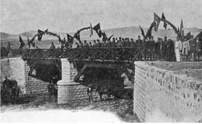
Kastamonu-İnebolu yolunda inşa edilen Kuruçay Köprüsü'nün açılış merasimi (1899)
