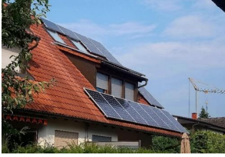
Şekil 3. Çatıda Ek Strüktür ile Uygulanan Fotovoltaik Paneller
