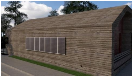
Şekil 8: Cephede ek strüktür ile kullanılan FV panel uygulaması (Cephe-1)
