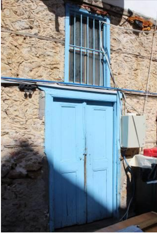
Şekil 28. Işıklıklı Kapı ve Kapazlama Kilit Sistemi
