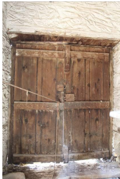
Şekil 24. Karma Kapı ve Kilit Sistemi
