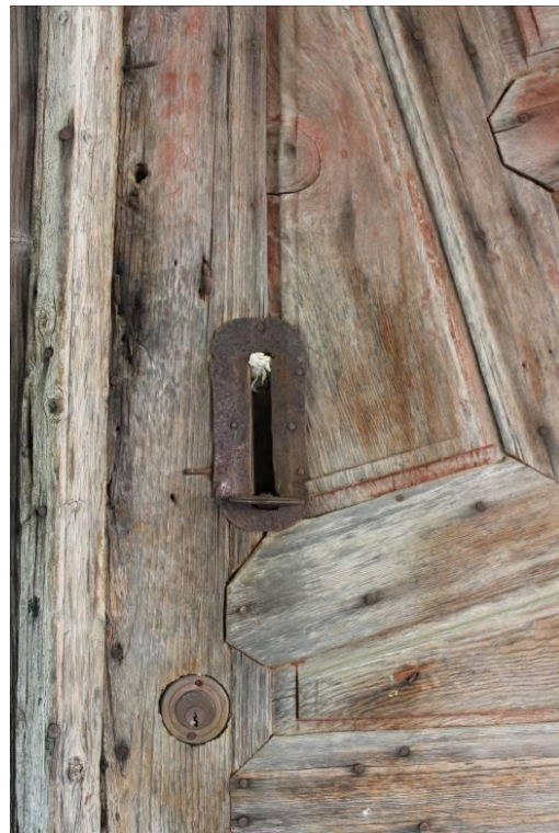
Şekil 14. Çift Kanatlı Tablalı Kapı ve Şıpdüşen Kilit Sistemi
