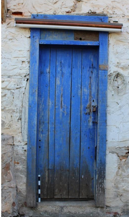
Şekil 7. Tek Kanatlı Çakma Kapı
