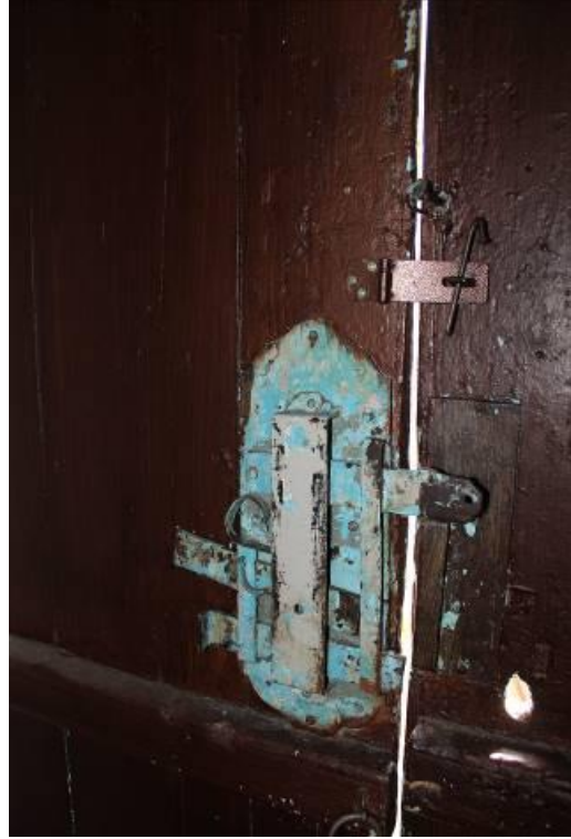
Şekil 28. Işıklıklı Kapı ve Kapazlama Kilit Sistemi
