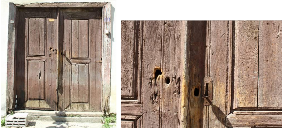
Şekil 25. Karma Kapı ve Şıpdüşen Kilit Sistemi
