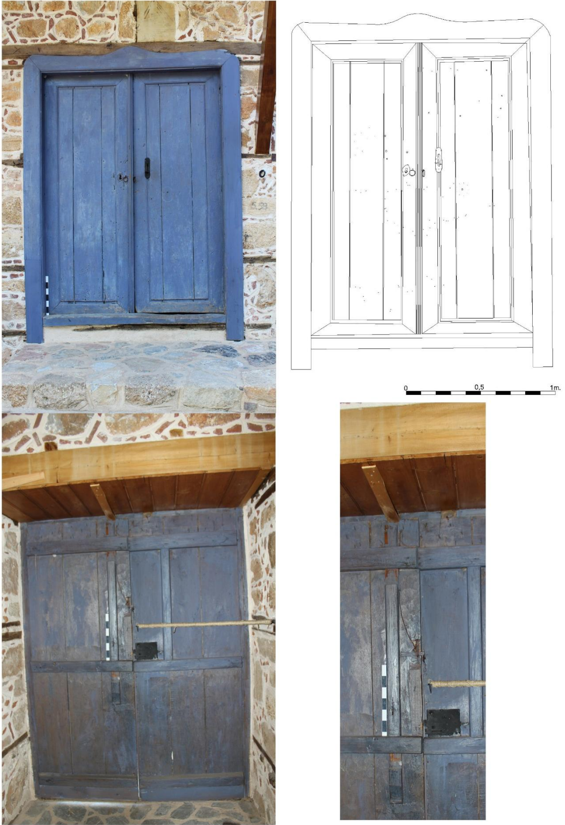
Şekil 15. Çift Kanatlı Karma Kapı ve Traka Kilit Sistemi
