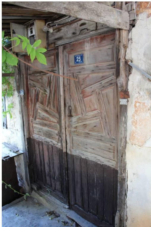
Şekil 14. Çift Kanatlı Tablalı Kapı ve Şıpdüşen Kilit Sistemi
