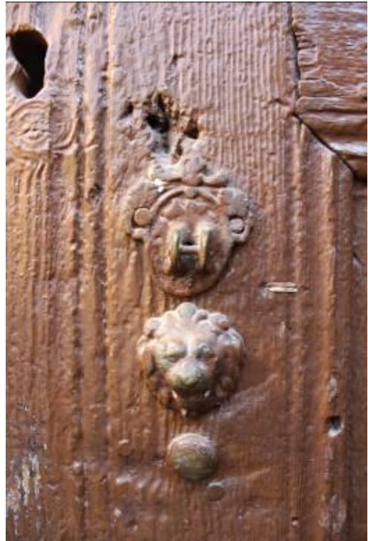
Şekil 29. Işıklıklı Kapı Tokmak ve Kilit Sistemi
