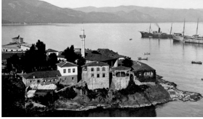
Fotoğraf 4. Sultan Selim (Hüdâvendigâr) Camisi'nin Kale'den görünüş (1900'lü yıllar) (M. Fatsa Arşivi)
