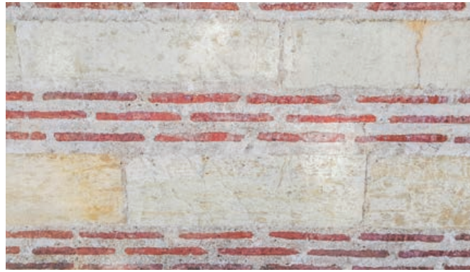
Şekil 2. Caminin duvar yapısı: Üç sıra tuğla arasında bir sıra kesme taş Akveren kireçtaşı (Akv).
