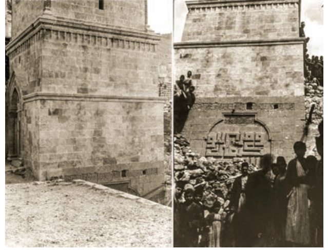
Şekil 5. Mardin Melik Mahmut (Savurkapı) Camii üçlü payanda düzenli kible cephesi. Şekil 6. 1899 (Oppenheim, 1930) ve 1911 (Gertrude Bell) yıllarında çekilmiş fotoğraflarda, minarenin, kaidesindeki şerit kitabesinden itibaren tamamen yenilediği, taş dokusunun farklılığından anlaşılmaktadır.
