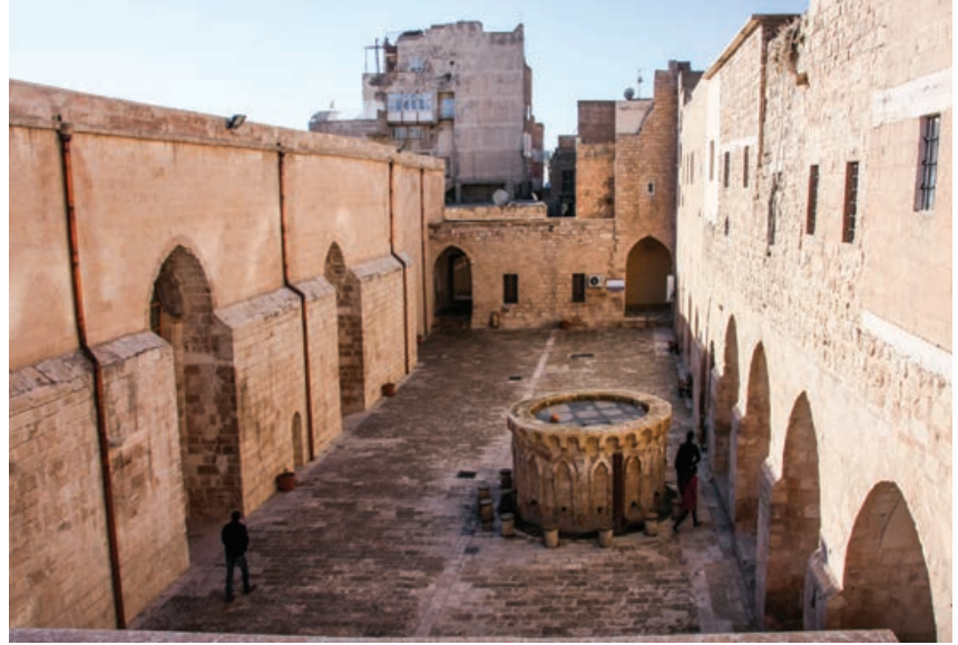
Şekil 10. Avludan bir görünüm (solda sonradan eklenen destek duvarı görülmektedir).
