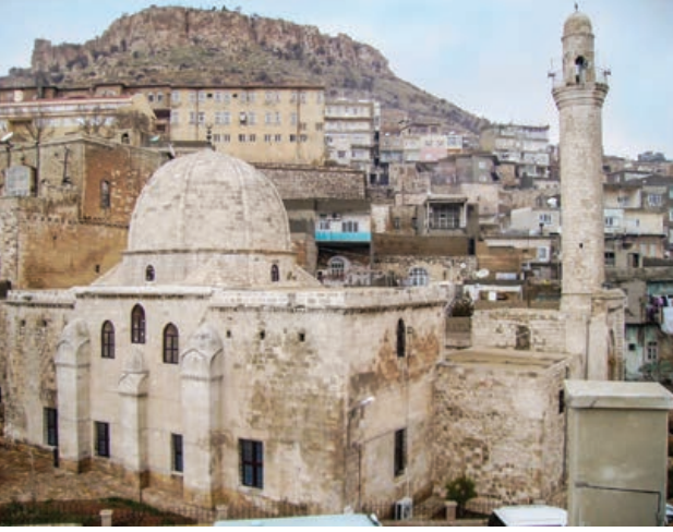
Şekil 5. Mardin Melik Mahmut (Savurkapı) Camii üçlü payanda düzenli kible cephesi. Şekil 6. 1899 (Oppenheim, 1930) ve 1911 (Gertrude Bell) yıllarında çekilmiş fotoğraflarda, minarenin, kaidesindeki şerit kitabesinden itibaren tamamen yenilediği, taş dokusunun farklılığından anlaşılmaktadır.
