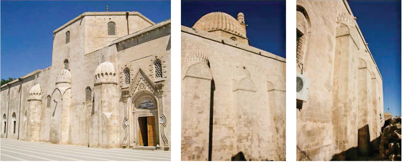
Şekil 4. Diyarbakır Silvan Ulu Camii (solda) ile Mardin Ulu Camii'nin (sağda) kible cephesi payandaları
