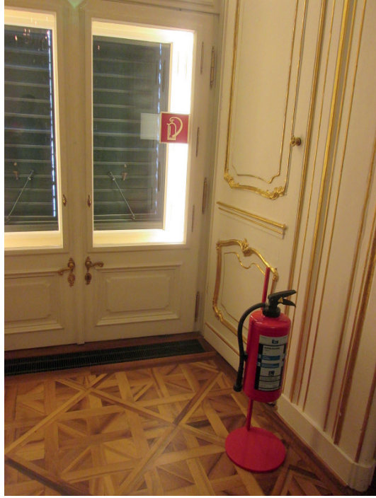
G.5 Viyana Schonbrunn Saray Müzesinde yangın söndürücünün tahribatsız olarak yerleřtirilmesi ve işaretlendirilmesi (A. Kuzucuođlu Arřivi)
