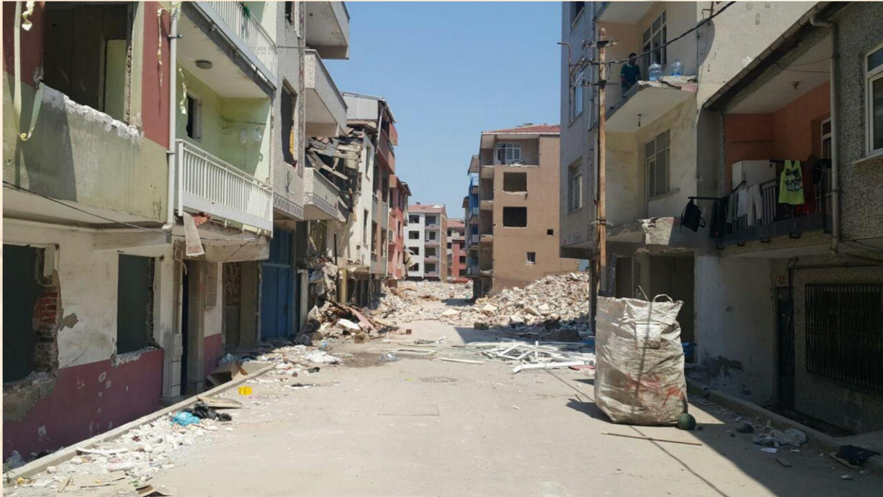
Mahallenin Bir sokağında Dönüşüm Projesi ile Terk Edilmiş Binalardan Bir Görüntü
