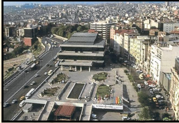
Şekil 11. Beyoğlu Meşrutiyet Caddesi'nde serbest yaklaşımla yapılmış TRT binası
