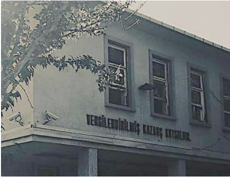
Şekil-2: Kadıköy Vergi Müdürlüğü binası üzerinde bulunan “Vergilendirilmiş Kazanç Kutsaldır” yazısı
