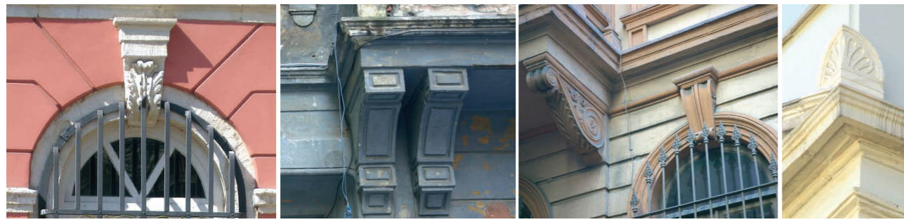
Şekil 13. (Soldan sağa) kilittası, T. İş Bankası Müzesi (Bahçekapı, 1892); payanda, Appts. Castorides (Beyoğlu Yeşilçam Sokak 27, 1905'ten önce); payanda ve kilittası, apartman (Beyoğlu Sakızağacı Caddesi 16, 1905'ten önce); ve antefiks, Apparts. Dikéos (konut, Galata Serdar-ı Ekrem Sokak 68; 1905'ten önce).
