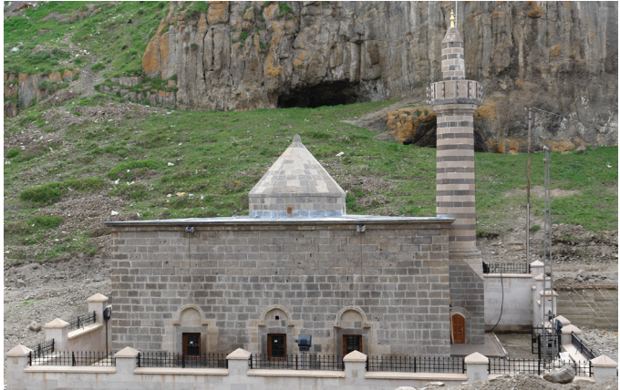
Fot. 3: Hınıs Ulu Camii doğu cephesi görünüşü.
