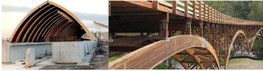
Şekil 14. Portland Toplu terminal binası (solda) (URL-10) ve Güney Prairie Köprüsü (sağda) (URL -12).
