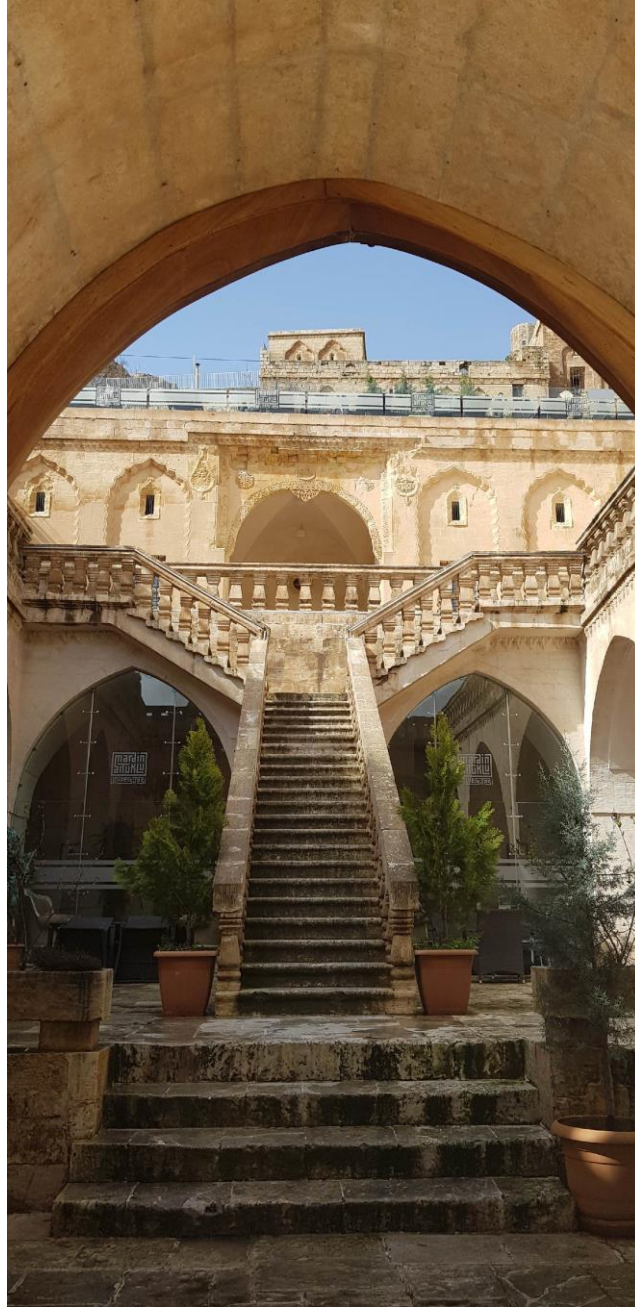
Şahtana Konağı Giriş Açıklığı
