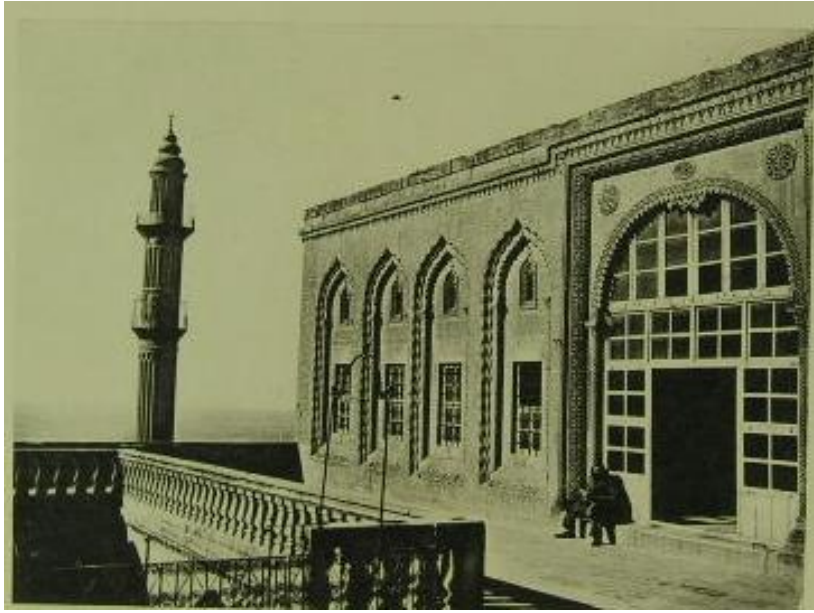
Şahtana Konağı Birinci Kat Görünüşü- A. Gabriel'den-1939
