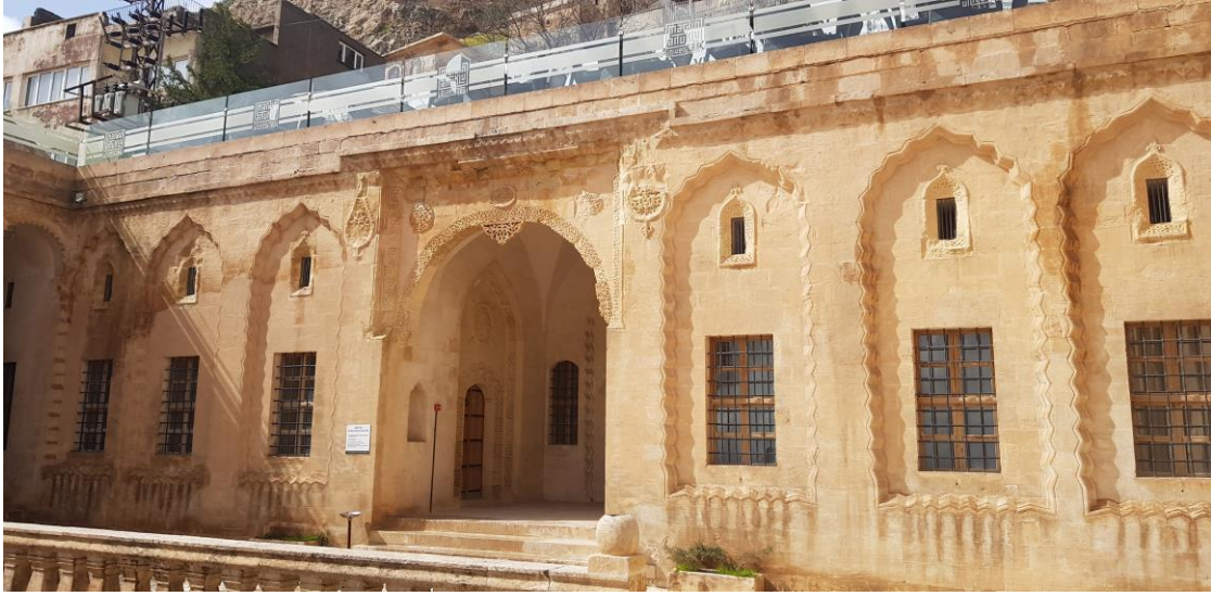
Şahtana Konağı Birinci Kat Eyvan Detayı
