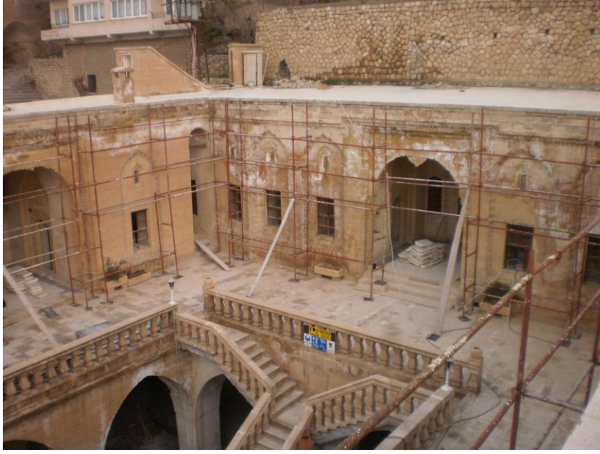
Şahtana Konağı Restorasyon Uygulamalarından Detay- MAÜ Arşivinden
