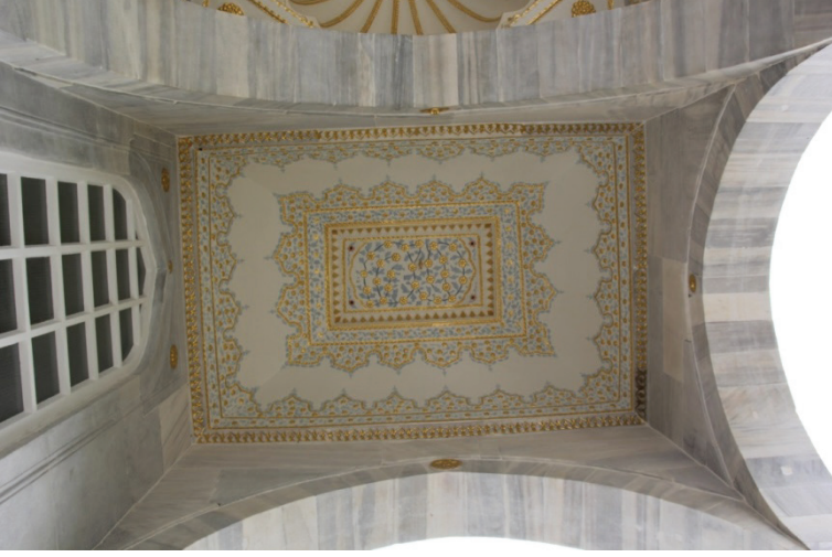
Res.9- Revakın yan bölümünün tonozu (2018)
