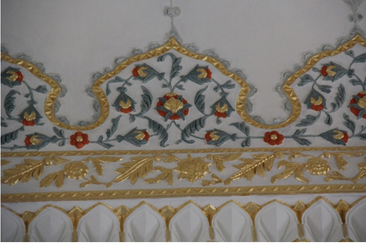
Res.23- Güneydođu eyvanı tonoz eteđi (2018)
