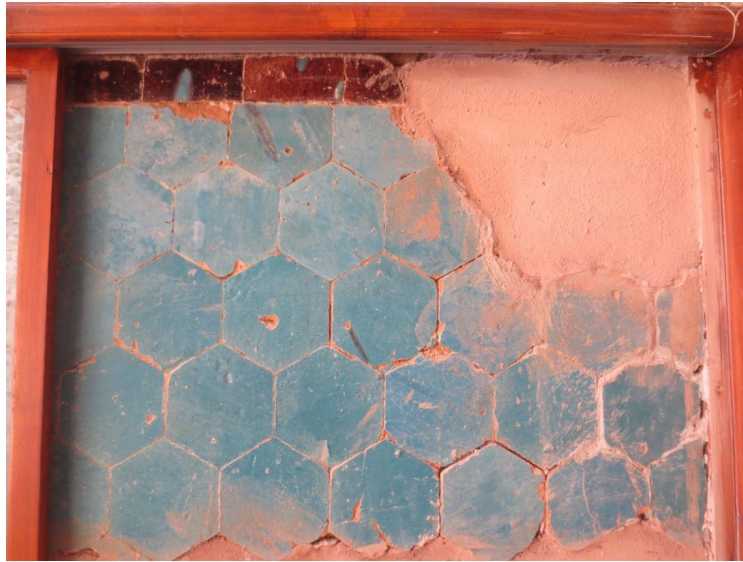
Resim 29. Yağıbasan Medresesi, güney eyvandaki çiniler (A.Denknlbant Çobanoğlu, 2017)
