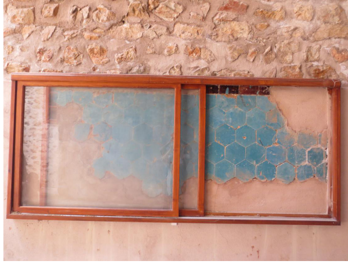
Resim 28. Yağıbasan Medresesi, güney eyvandaki çiniler (A.Denknlbant Çobanoğlu, 2017)
