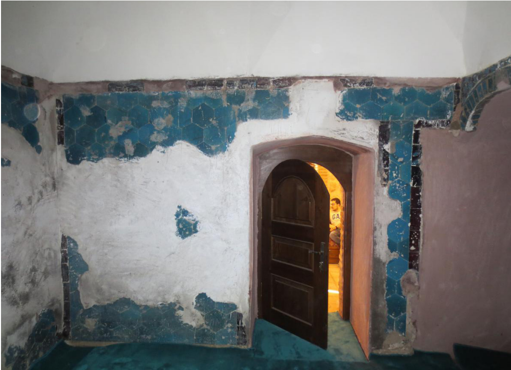
Resim15. Türbenin kuzey duvarı (A.Denknlbant Çobanoğlu, 2017)
