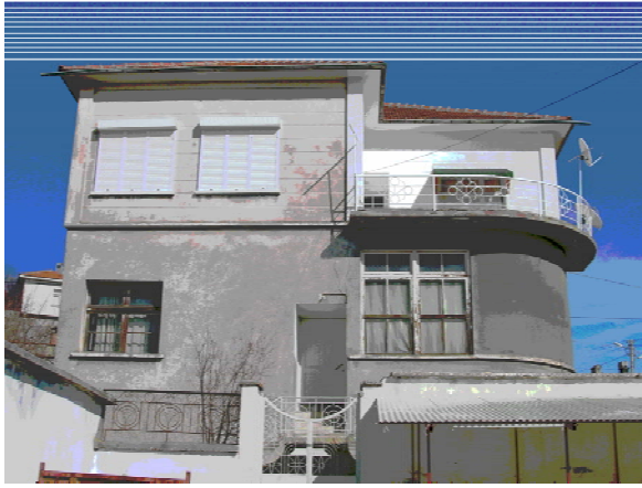
Şekil 20. Halk evi olması öngörülen yapı (Building proposed to be re-used as community house)
