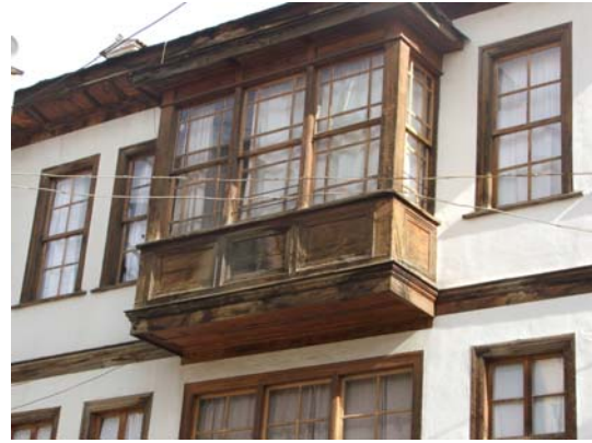
Şekil 11. Çıkma detayı (Detail of projection)
