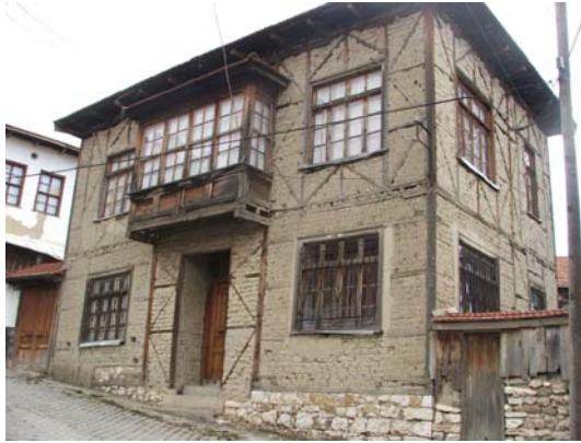
Şekil 13. Ahşap ve kerpicingin strüktürel olarak kullanım örneği (An example of mud-timber construction)
