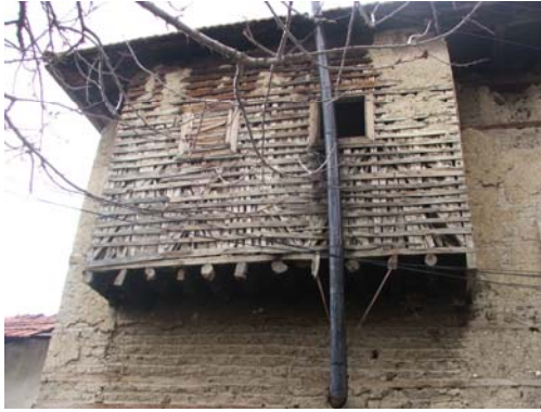
Şekil 14. Ahşap ve kerpicingin strüktürel olarak kullanım örneği (An example of mud-timber construction)
