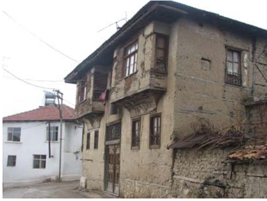
Şekil 12. Ahşap ve kerpicingin strüktürel olarak kullanım örneği (An example of mud-timber construction)
