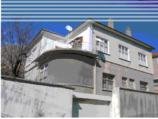
Şekil 19. Halk evi olması öngörülen yapı (Building proposed to be re-used as community house)
