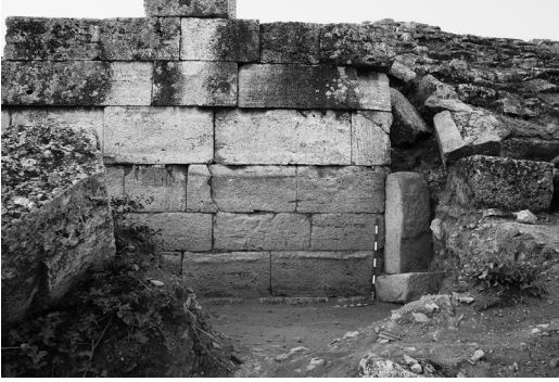
Fig. 12 Doğu parados duvarının çalışmalar sonrasındaki durumu.
