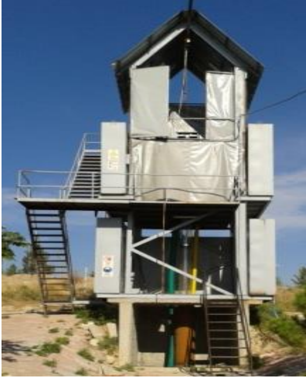
Şekil 2. Derin kuyu test kulesi.
