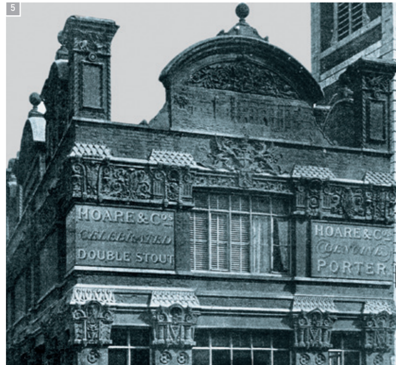
Şekil 5. Portland çimentolu sıvalarla dış cephede yerinde uygulama, Baynard Castle Oteli, Londra, W. Millar, 1874 (Millar, 2004; s. 231).
