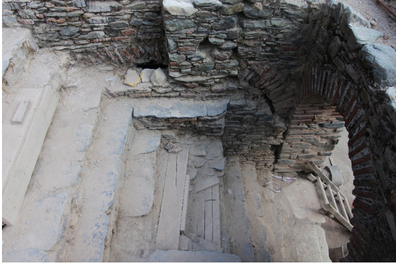
Fot.11- Üst kata çıkışı sağlayan merdivenden ayrıntı.
