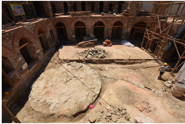
Fot.7- Çalışmalar sırasında avlunun görünüşü.
