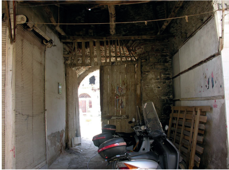
Fot.3- Giriş eyvanının çalışma öncesi görünüşü.
