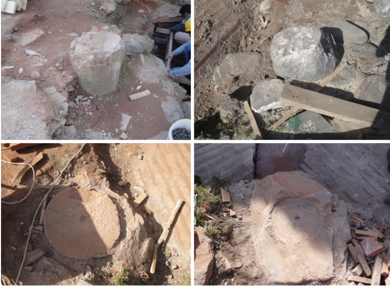
Fot.12- Üst kat revakına ait, yerinde tespit edilen sütun ve altlıkları.
