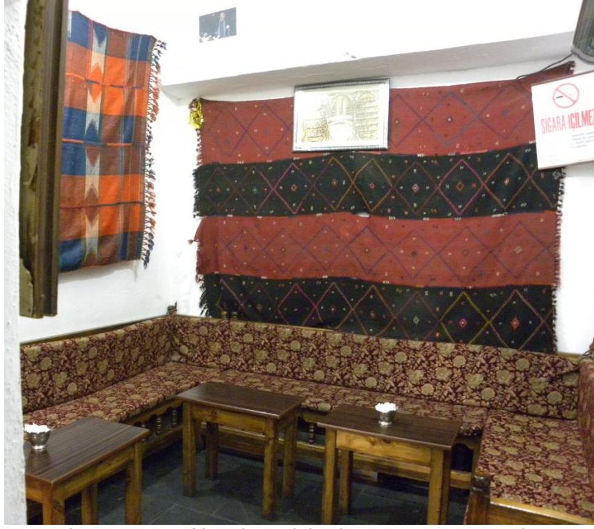
Şekil 9: Özgün Dokuyu Bozan Eklentiler: Elektrik Tesisatı, Doğramalar, Tablolar
