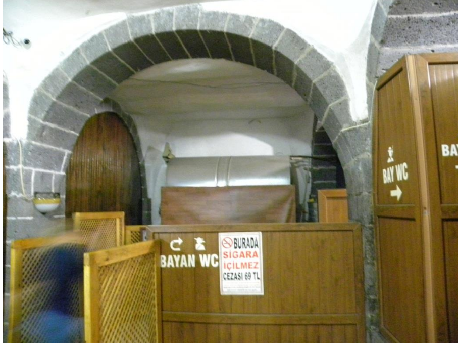
Şekil 15: Özgün Dokuyu Bozan Eklentiler: Elektrik ve Sıhhi Tesisat Elmanları, Pvc Doğramalar, Su Deposu
