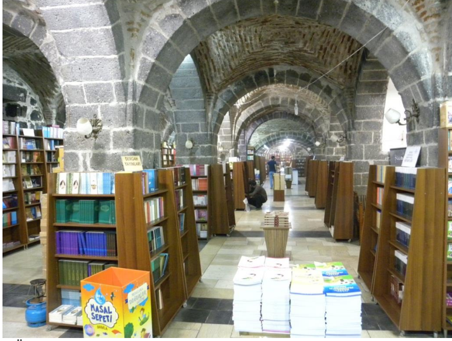
Şekil 13: Özgün Dokuyu Bozan Eklentiler: Elektrik Tesisatı, Raflar, Mobilyalar
