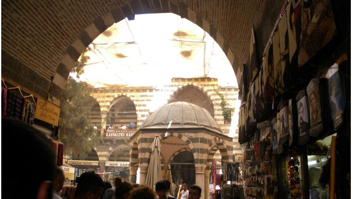
Şekil 6: Özgün Dokuyu Bozan Eklentiler: Elektrik Tesisatı, Gölgecikler, Tabelalar, Bitkiler
