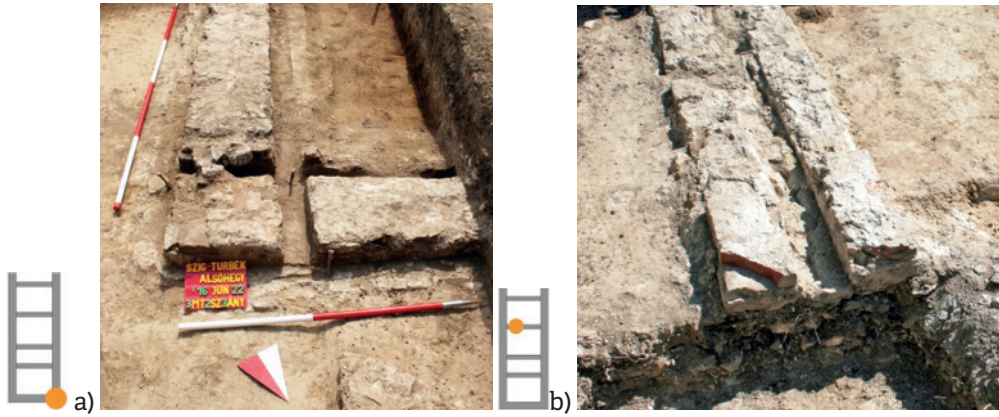
Resim 30-a: Tekke dış duvarında çiftli hatıl yuvaları ve in situ çiviler; b: İç duvarda tekli hatıl yuvası
