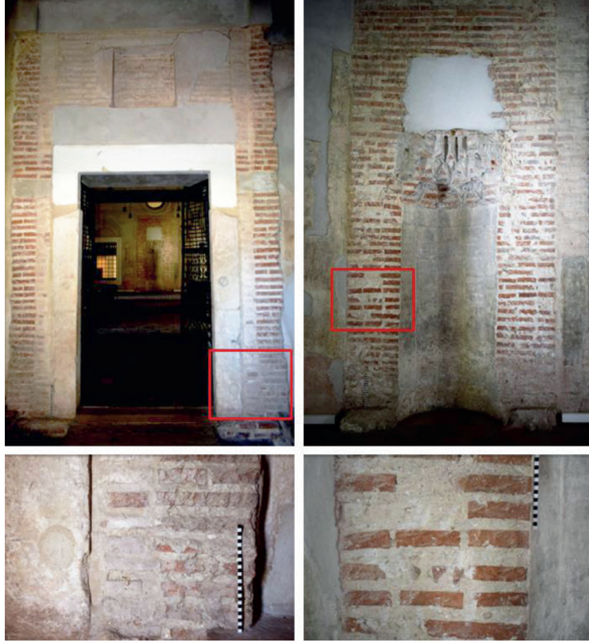
Resim 47: Zigetvar Kalesi'nde Sultan Süleyman Camii'nde tuğla örgü örnekleri ve detayları; sol üstte ve altta portal; sağ üstte ve altta mihrap
