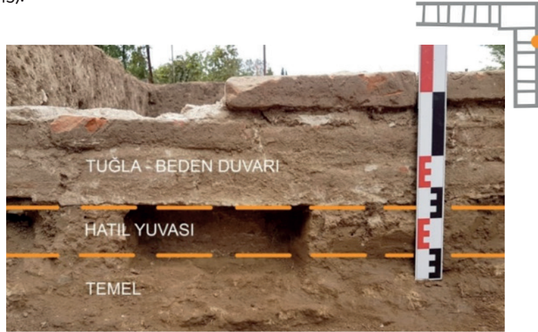
Resim 43: Tekkede, temel üzerinde, toprakla dolmuş ve bir bölümü temizlenmiş hatıl yuvası
