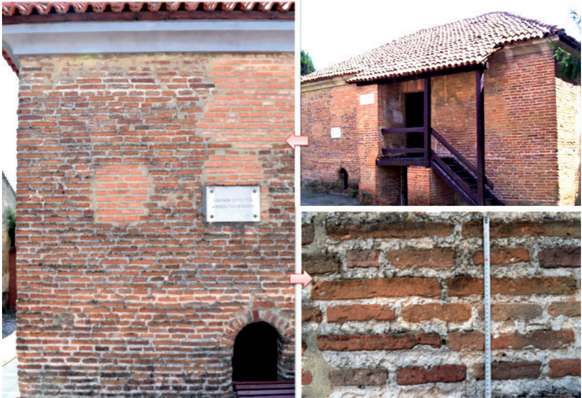
Resim 48: Zigetvar Türk Evi Müzesi giriş cephesi ve tuğla örgü detayı
