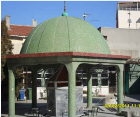
Resim 32. Şadırvanın Onarımdan - Önceki Görünümü.
