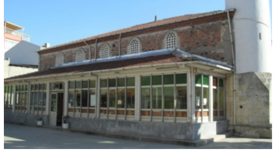
Resim 14. Son Cemaat Yerinin Onarımdan Önceki Görünümü.
