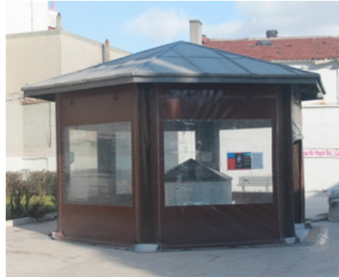
Resim 33. Şadırvanın Onarımdan -Sonraki Görünümü.
