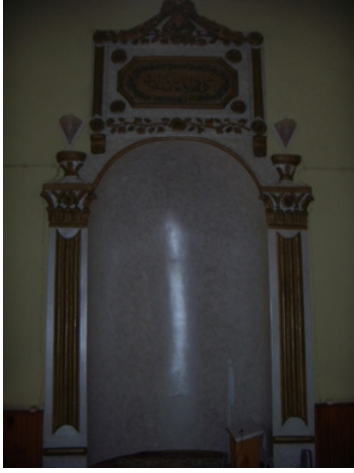
Resim 25. Mihrabın Onarımdan Önceki Genel Görümü
