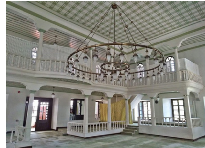
Resim 24. Onarımdan Sonra Harim Kısmının Tavanından - Görünüm
