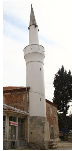
Resim 8. Minarenin Onarımdan-Önceki Görünümü
