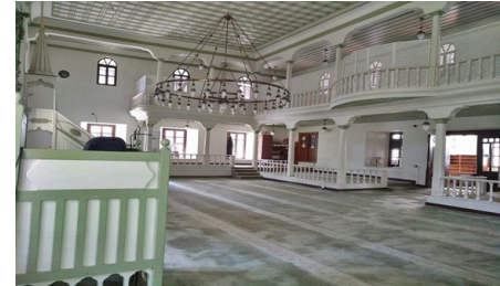
Resim 23. Onarımdan Sonra Harim Kısmının Tavanından - Görünüm
