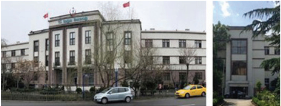
Fot. 5: Ana cephe ve arka girişten görünüm
