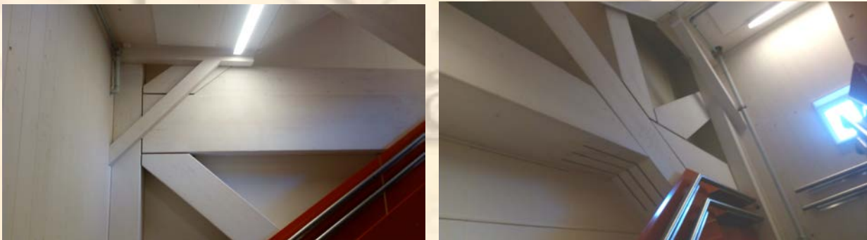
Şekil 14. Ahşap bağlantı detayları ve yuvalarının yangın koruması (N. Gül arşivinden)
