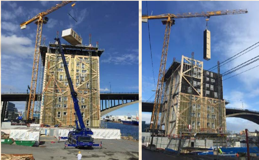
Şekil 12. The Tree yapısında prefabrike modül (solda) ve CLT asansör shaftının yerleştirilmesi (sağda) (Kleppe, 2017).
