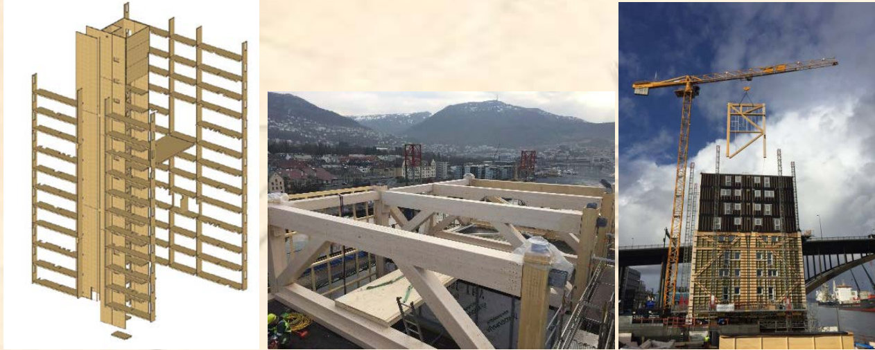
Şekil 13. Lamine ahşap ve CLT elemanların kullanımı ve yerleştirilmesi (Kleppe, 2017).
