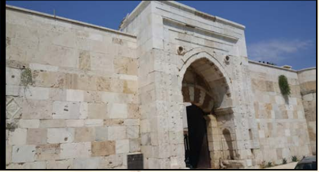
Foto 2. Kervansarayın Taç Kapısı, (2019)
