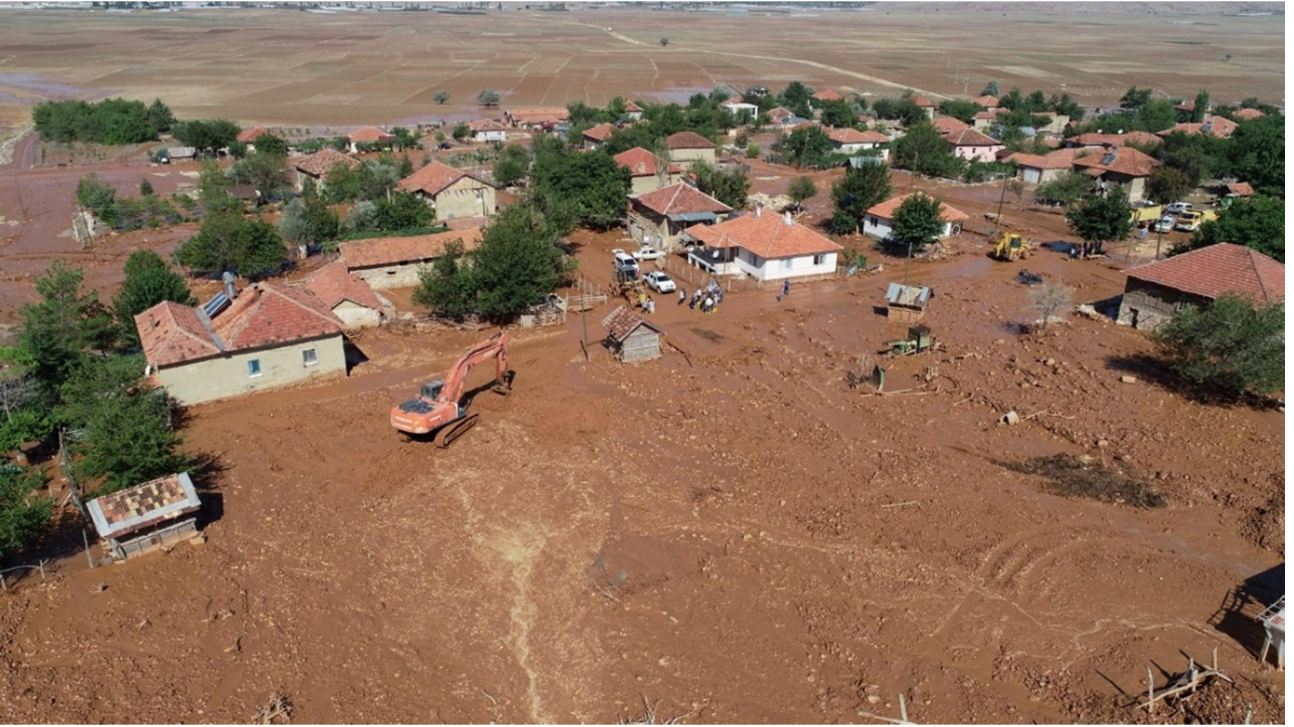
Foto 4. Salur kırsal mahallesinde gerekleřen afet sonrası temizlik alıřmaları
