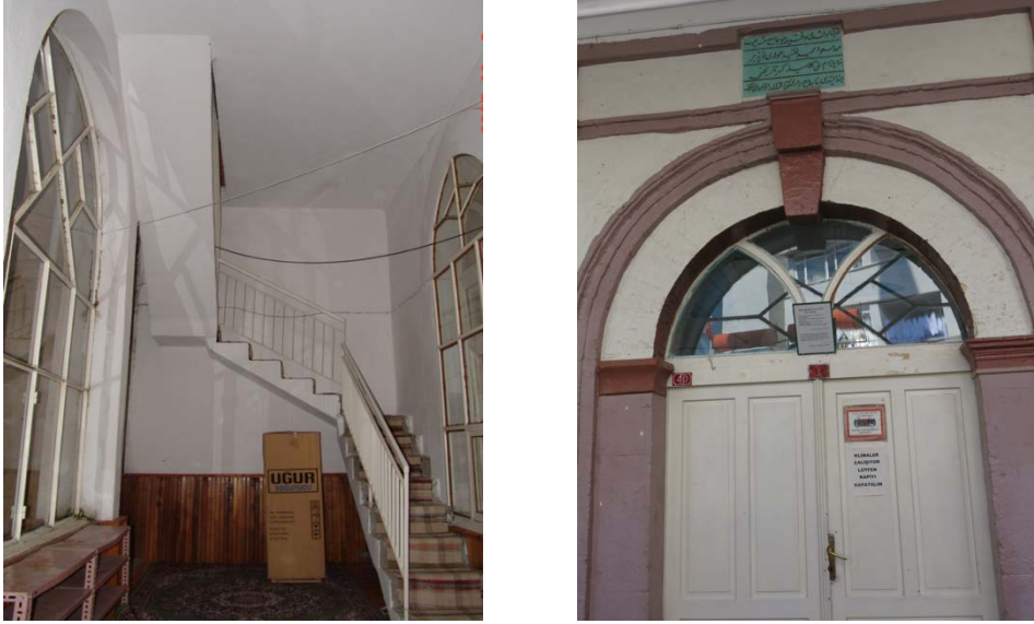
Fig. 5-6. İbradı Süruri Vezir Paşa Camii Son Cemaat Yerinden Üst Kata Çıkış ve Giriş Kapısı
