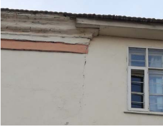
Fig. 17. İbradı Süruri Vezir Paşa Camii Kuzey Doğu Duvarında Son Cemaat Yeri İle Birleşim Noktası
