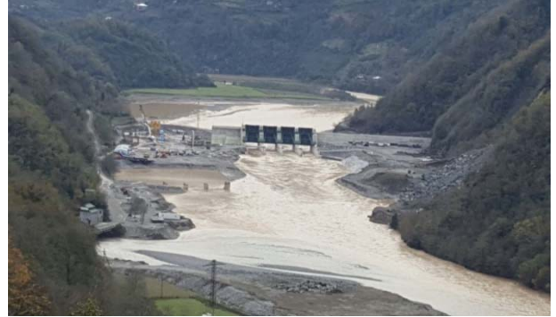
Şekil 2: Kirnati-Khelvachauri I Hes şantiyesi ön yüz fotoğrafı
