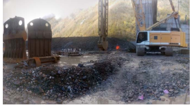
Şekil 6: Kirnatı-Khelvechauri I Hes şantiyesi diyafram duvar uygulamasından bir görünüm
