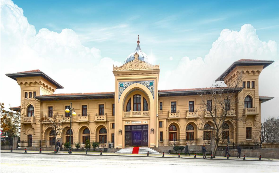
(Foto:9 ) Giriş kapısı teras kat
