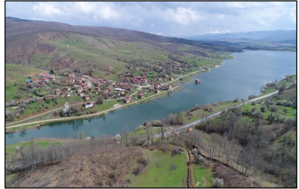
Şekil 3. Günyurdu Barajı, drone ile fotoğraf çekimi (Orijinal 2019)
