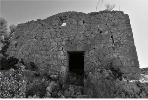
Fig. 15. Tersane Koyu Balık Sosu İşliği Cephe Görünümü
