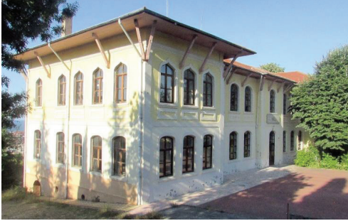
Fot. 11: Orhan Gazi İlkokulu Giriş ve Yan Cephesi (2018, N. Benli Yıldız)
