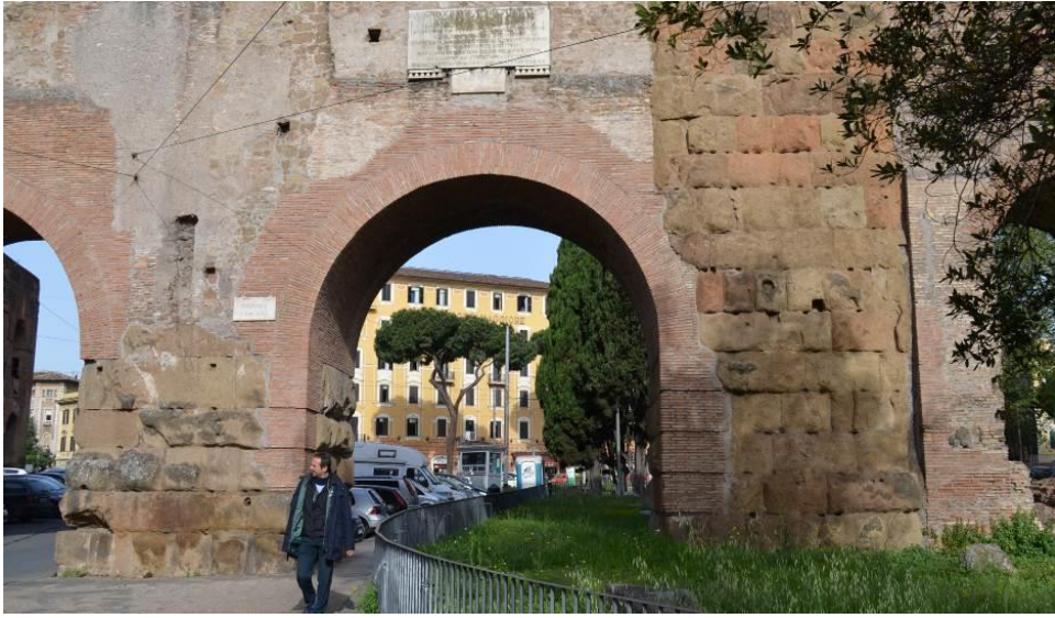
Şekil 3. Roma kentinde gözlemlenen taş anıt yapıların tuğla örgü ile bütünlenmesi (Kafa Duran, E. Kişisel arşiv, 2016).
