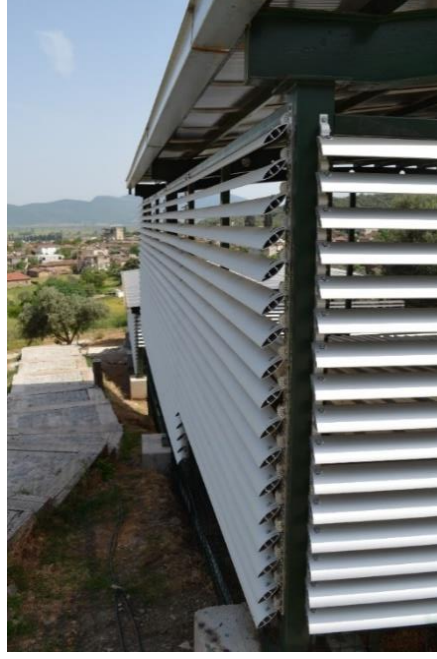
Şekil 17. Metropolis Resepsiyon Salonu cephesinde kullanılan alüminyum paneller (Kafa Duran, E. Kişisel arşiv, 2015)
