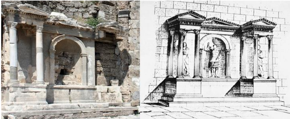
Şekil 4. Side Vespasian Anıtı çimento harçlı onarım sonrası durumu ve restitüsyonu (Side Vespasian Anıtı, b.t.)
