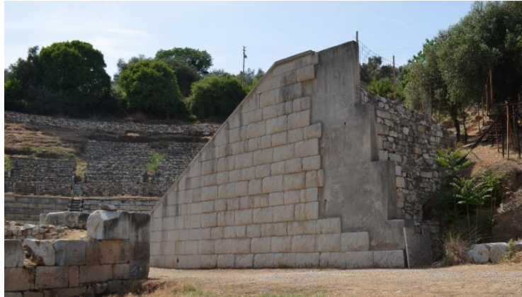
Şekil 13. Tiyatro analemma duvarında bosajlı uygulama ve betonarme sistemle oluşturulan basamak (Kafa Duran, E. Kişisel arşiv, 2015)
