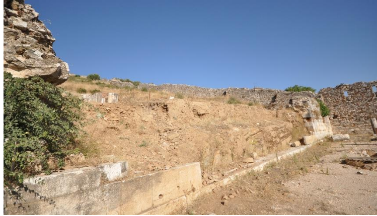
Şekil 20. Stoa arka duvarının yok olması sonucu görülen ana kaya ve oluşan toprak kayması (Metropolis kazı arşivi, 2013)
