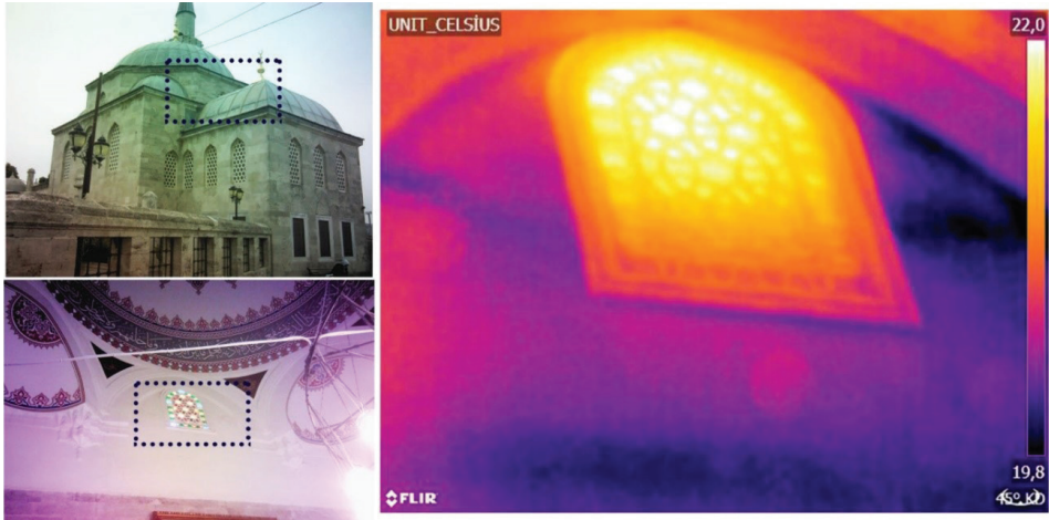
G. 15. Cami kuzeydoğu iç duvar yüzey sıcaklık dağılımı (Emre Kışalı, 2019)
