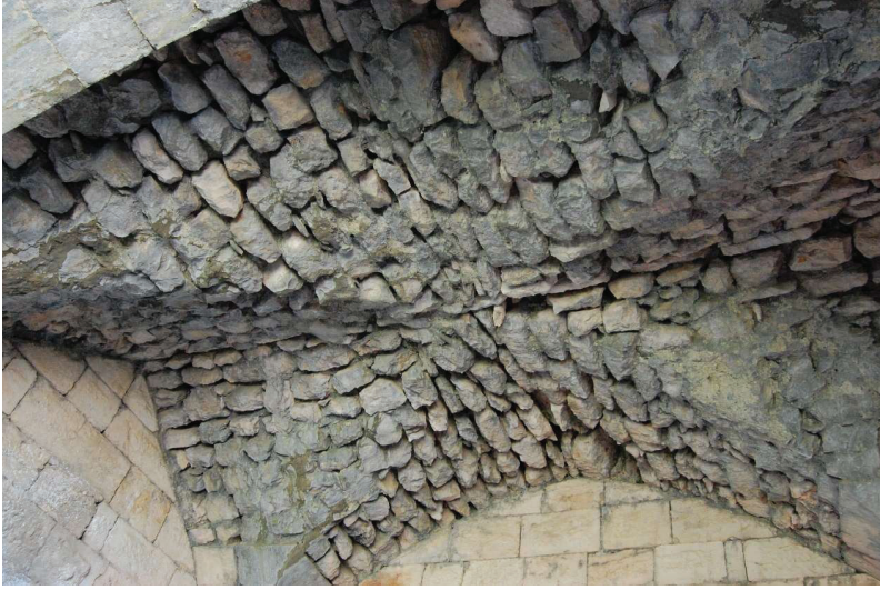
G. 13. Çandır Kalesi E Konut yapısı E1 bölümü üst örtüsü (H. Sözlü, 2019).
