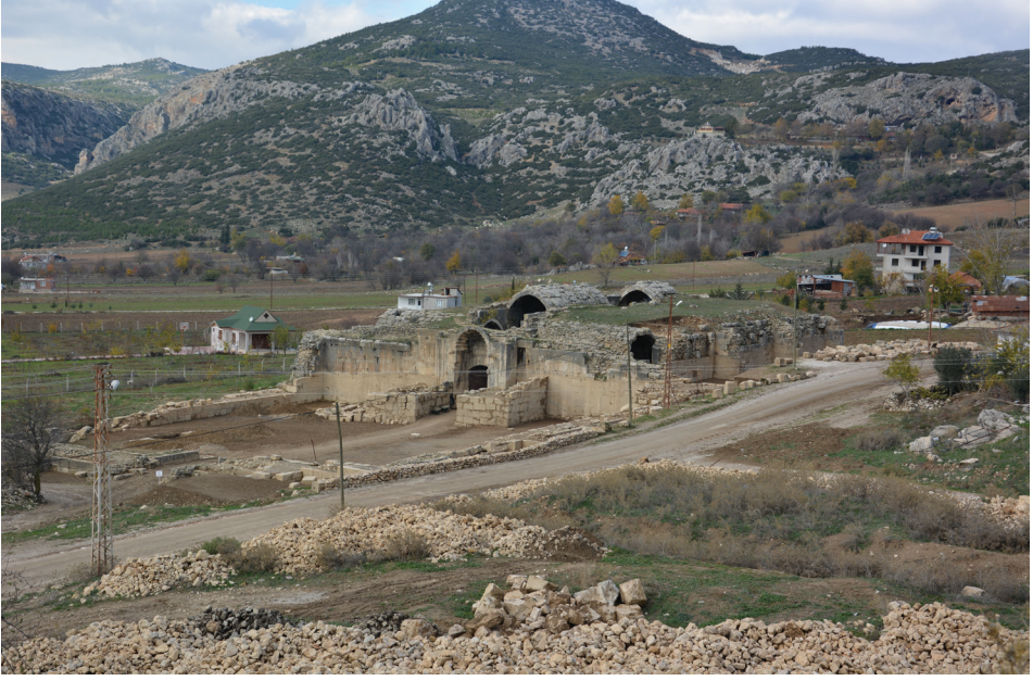
Fot. 3: Kazı çalışmaları sonrası güneydoğudan genel görünüş.
