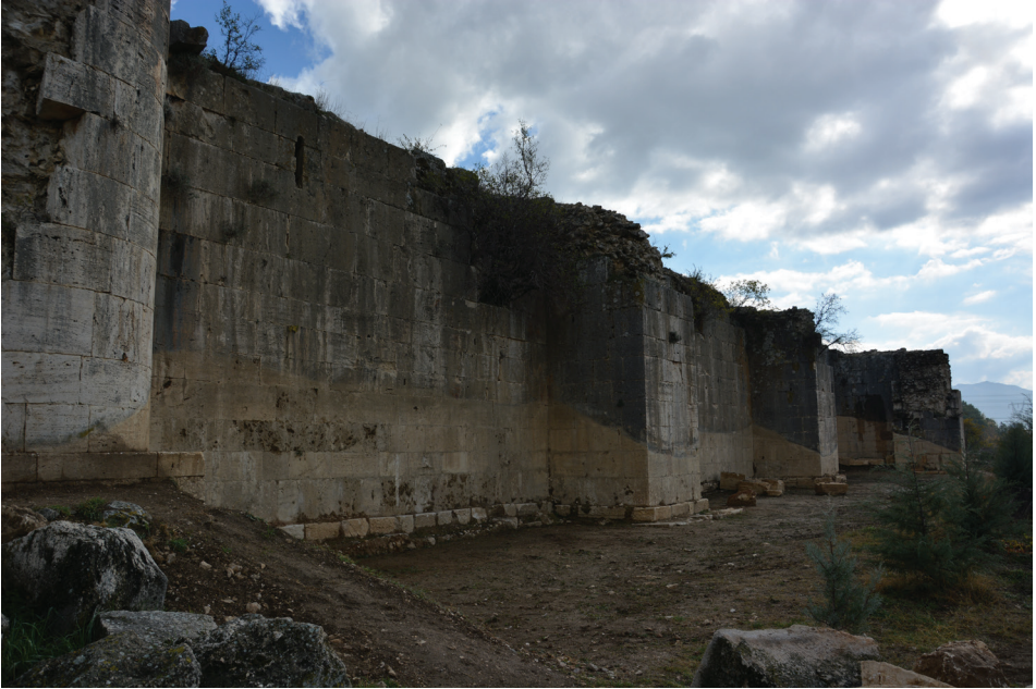
Fot. 15: Kapalı kısım batı cephesi.
