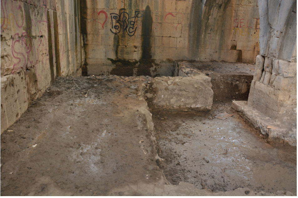
Fot. 24: Kapalı kısımdaki havuz.
