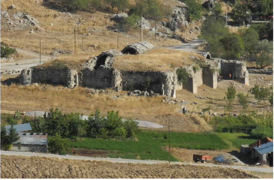
Fot. 14: Kazı çalışmaları sırasında kuzeybatıdan genel görünüş.
