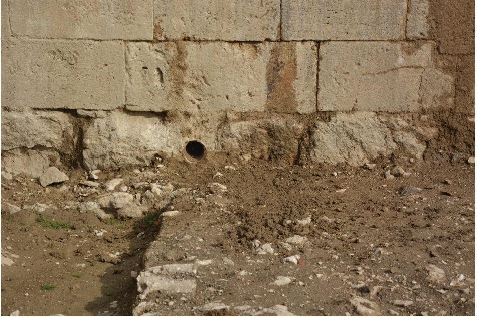
Fot. 9: Avlu dođu duvarında pişmiş toprak künk.
