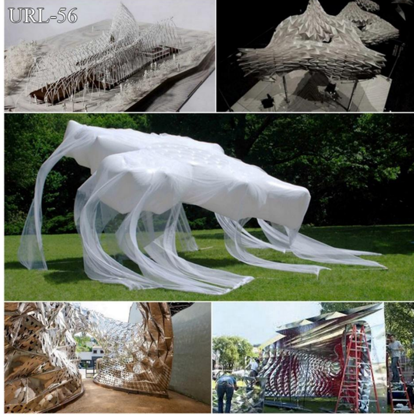
Şekil 16. Pavilyon yapılarında dijital teknolojinin kullanımı
