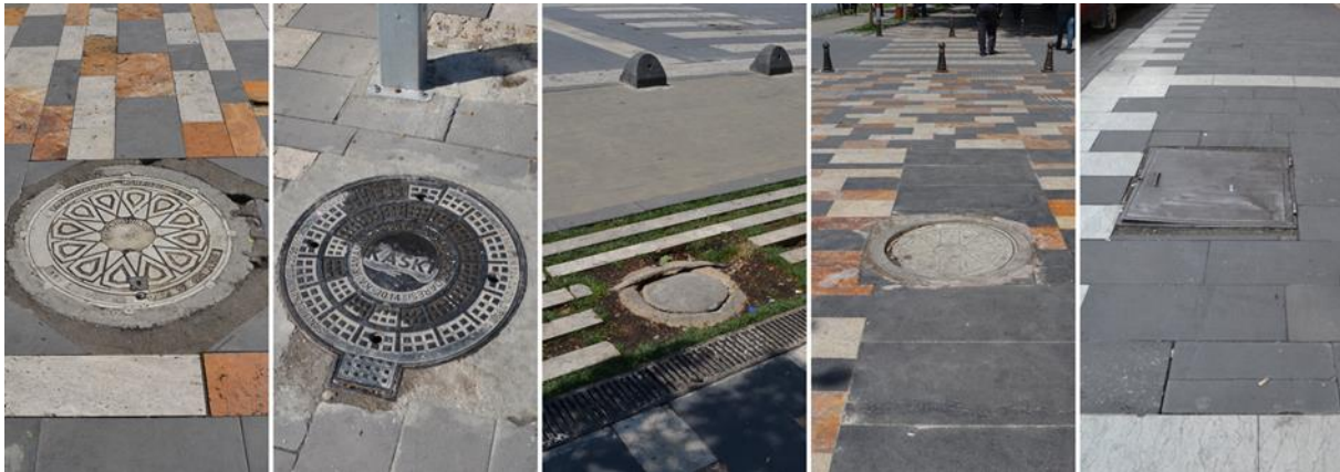
Şekil 4.6. Çalışma alanında mevcut altyapı tesisleri bakım kapakları
