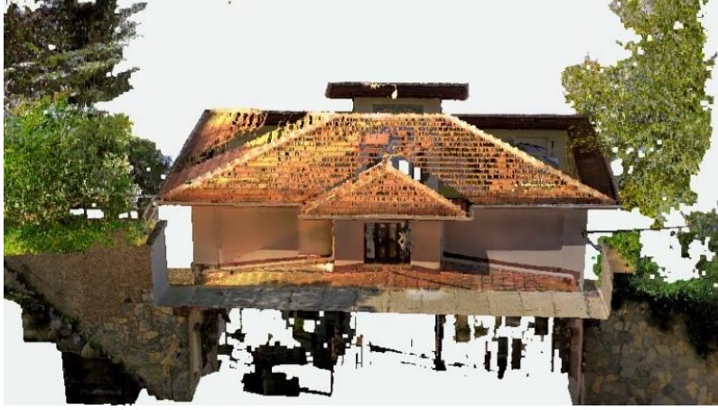
Şekil 6. Nokta bulutlarından üretilmiş binanın kısıtlayıcı arka cephesi
