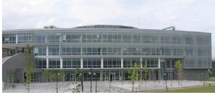
Şekil 7. Karabük Valilik Binası güney cephesi
