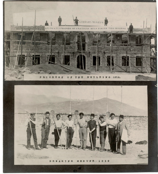
Şekil 4. Yapım aşamasındaki kütüphane-müze binası (United Church of Christ 1912, Salt Araştırma, Anadolu Koleji, Merzifon Arşivi)
