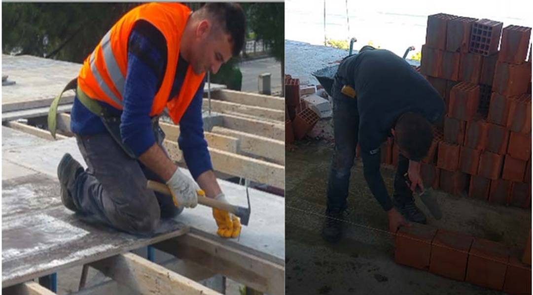
Şekil 2. Alt seviyede gerçekleştirilen tuğla örme ve kalıp çakma işleri ("Molding" and "Bricklaying" work performed in the lower working position)
