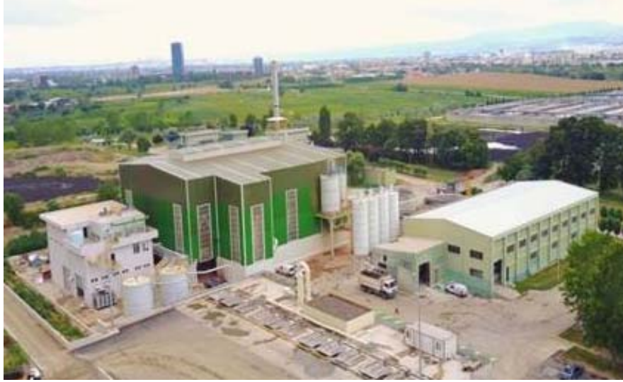
Şekil 1. Tesisin genel görünümü (General view of the incineration plant)
