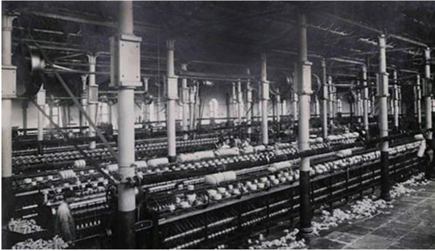
Şekil 1. Feshane binası iç mekânı ve çelik prefabrik taşıyıcı sistemi [9].
