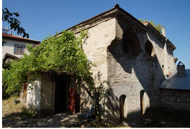
Resim 13: Batı Cephe, Kuzeydoğuya Bakış
