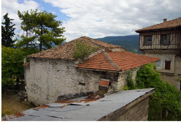
Resim 14: Örtü Sistemi, Güneydoğuya Bakış
