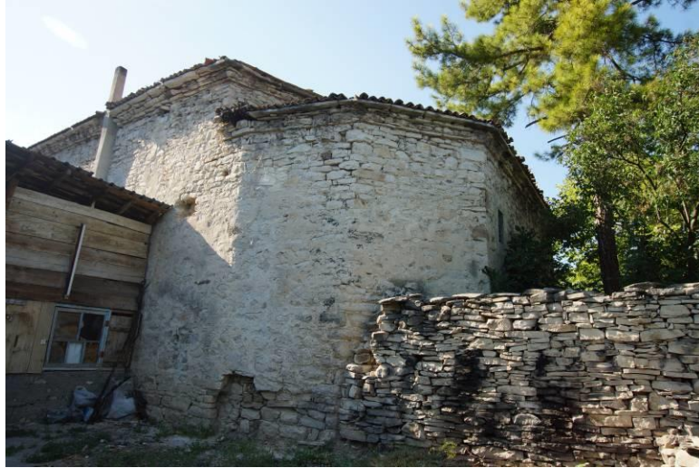
Resim 5: Apsis, Güneydoğu Cephe, Kuzeybatıya Bakış
