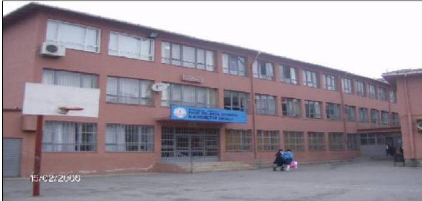
Şekil 1: Mevcut okul binasının genel görünümü
