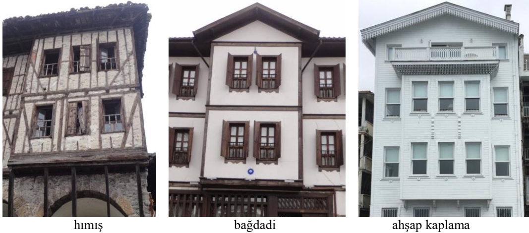
Şekil 1. Türkiye’deki geleneksel ahşap karkas yapılarda duvar oluşumu
