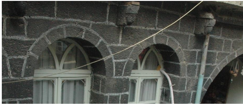
Fot. 13: Savaş Mahallesi Küçük Sürgü Sokak No:2 (konsollar)
